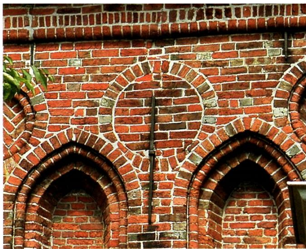
7 Een van de trekankers die zijn bevestigd aan een plafondbalk
