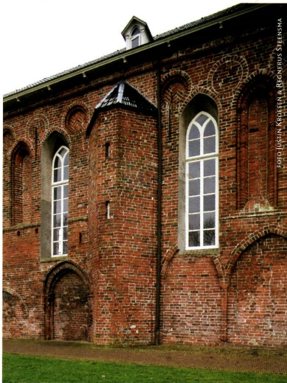
4 De gedeeltelijk uitgebouwde traptoren tegen de noordmuur
